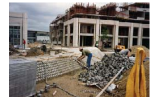
4 et 5 - Pose des pavés de granit gris et des galets de marbre blanc.
