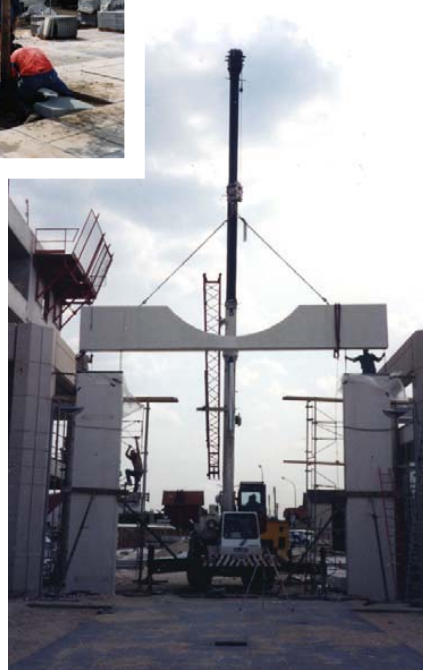
16 - Installation d'un des piliers de la première porte, soutenu par une grue, dans les fondations préparées.
